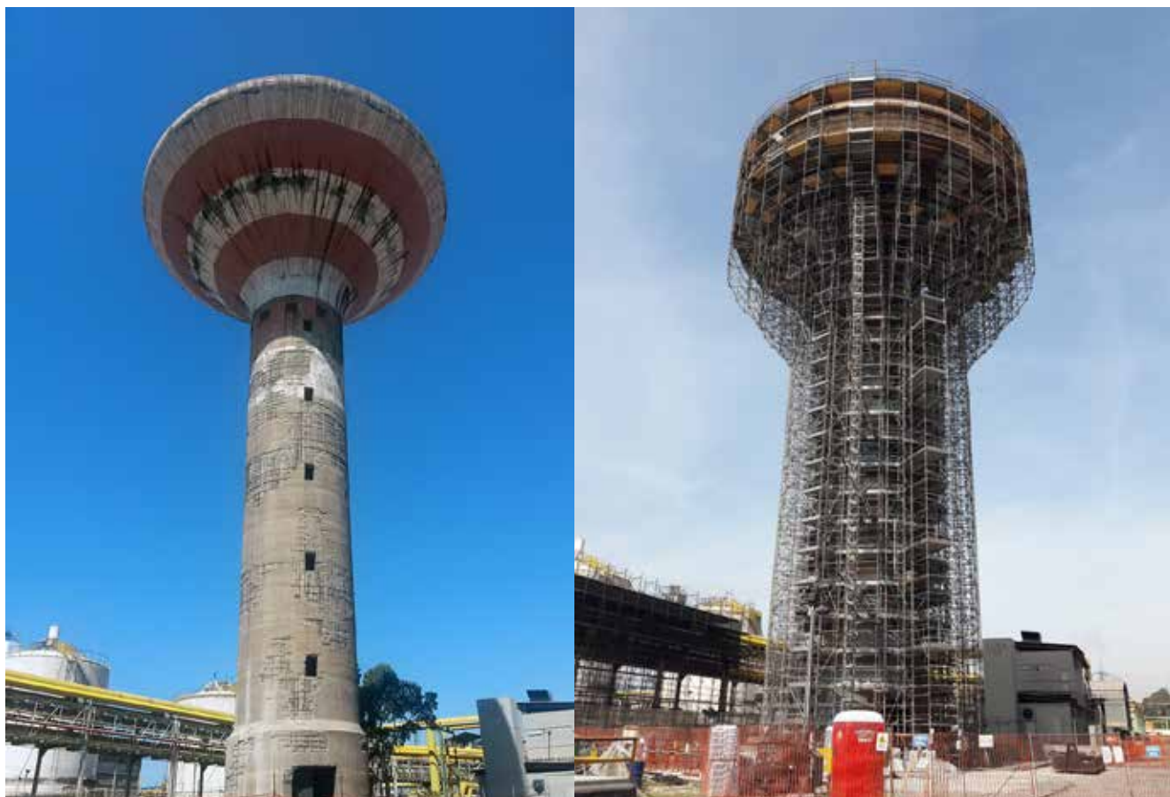
Lavori di ripristino della Torre piezometrica TNA2
