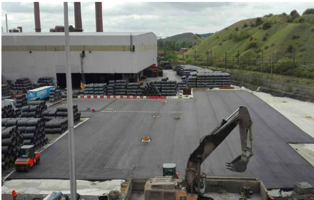
Thy Marcinelle - (Belgio): Realizzazione pavimentazione per stoccaggio bobine
