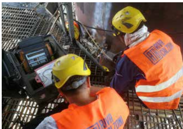
Controllo Ultrasonoro TODFT reattori Mangalore
