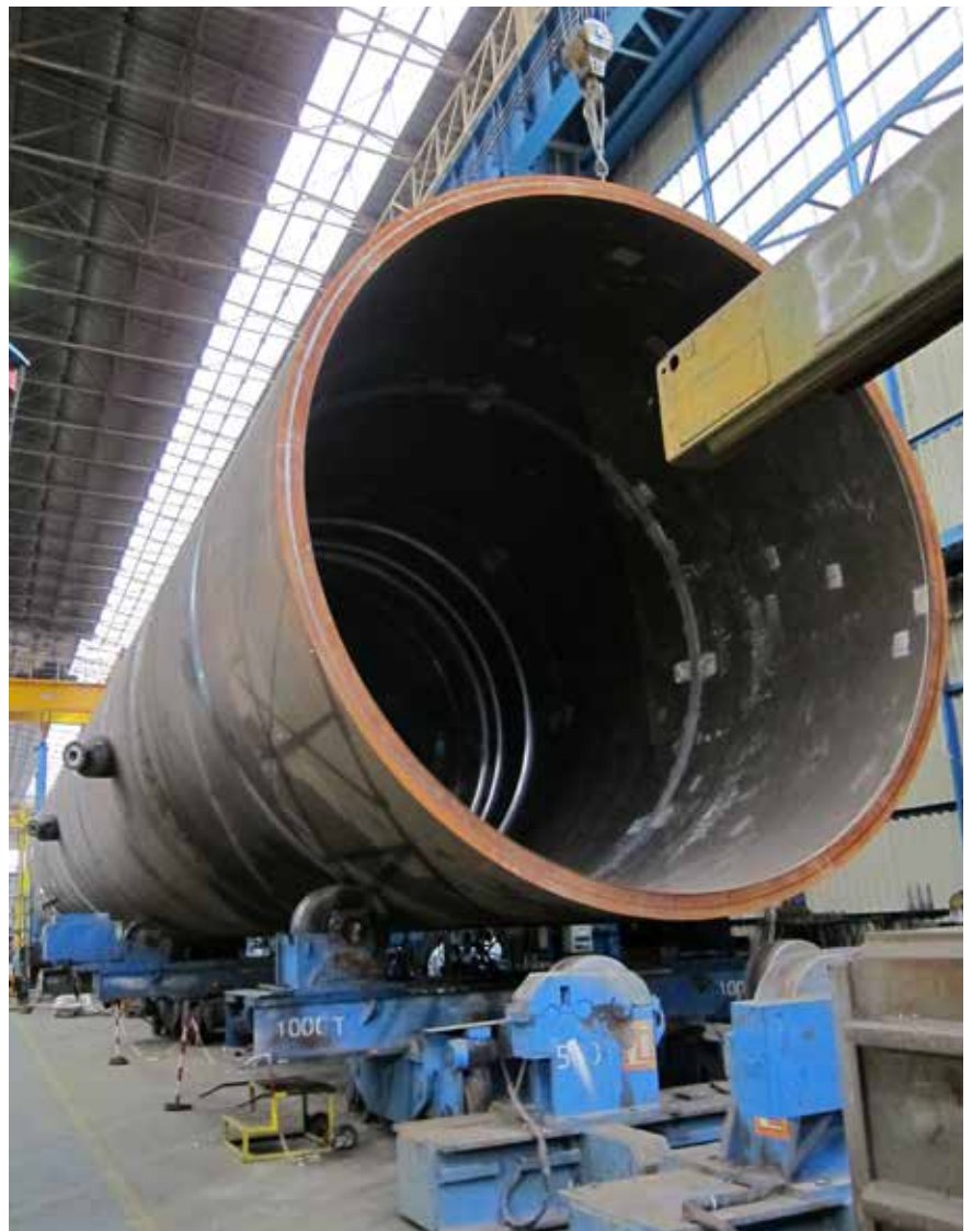
Le fasi di assemblaggio nello stabilimento di Porto Marghera, Venezia.
