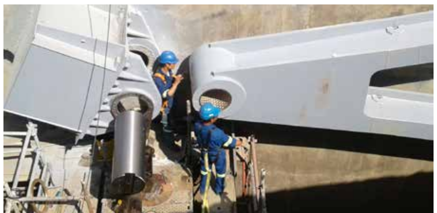
Montaggio dei bracci delle paratoie radiali
