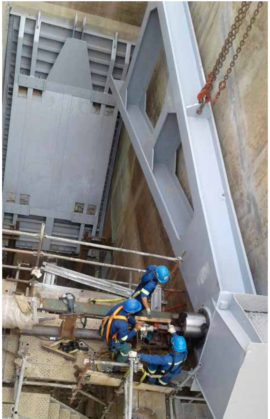
Montaggio dei bracci delle paratoie radiali
