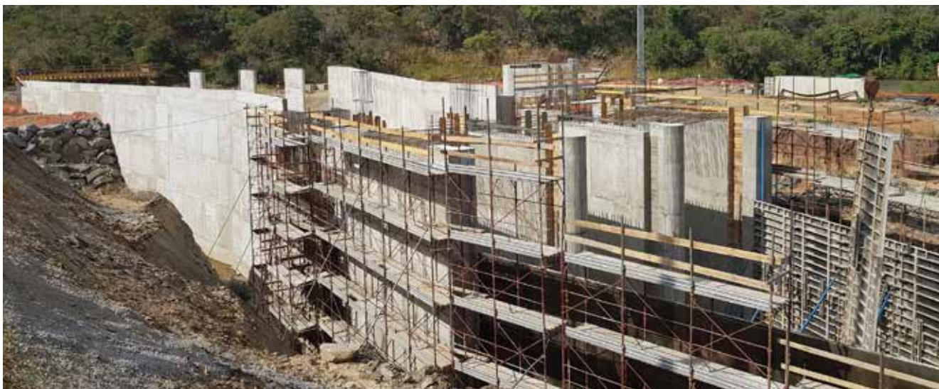
La progressione delle opere civili di HPP2 curate da Pac Spa.
