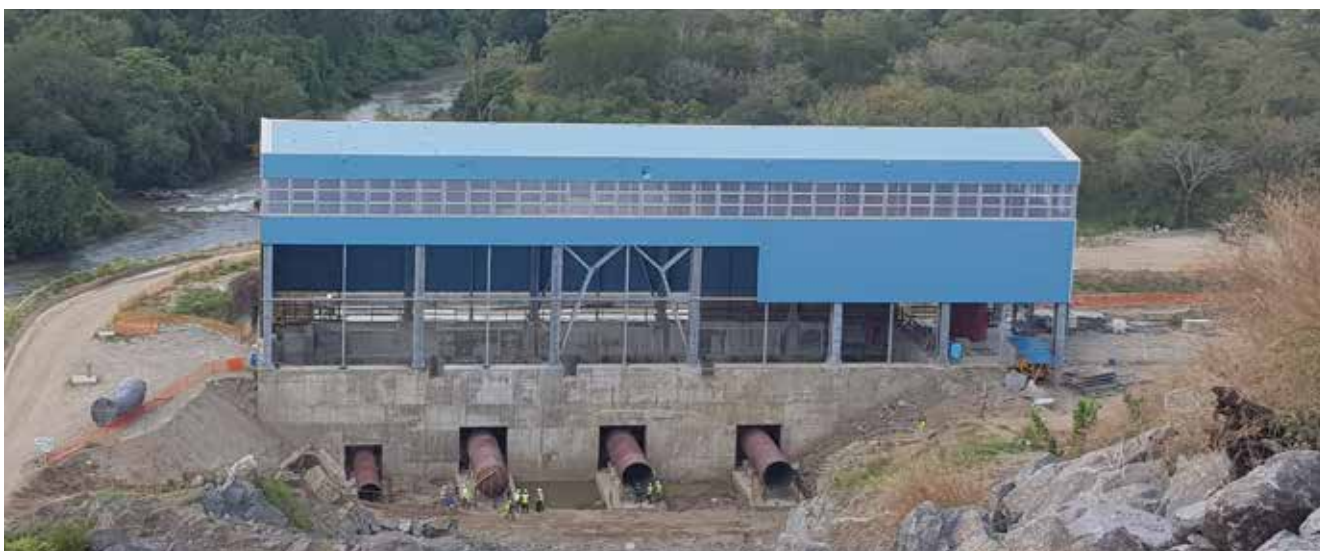
La power house nella quale verranno installati i panconi dello scarico turbine.
