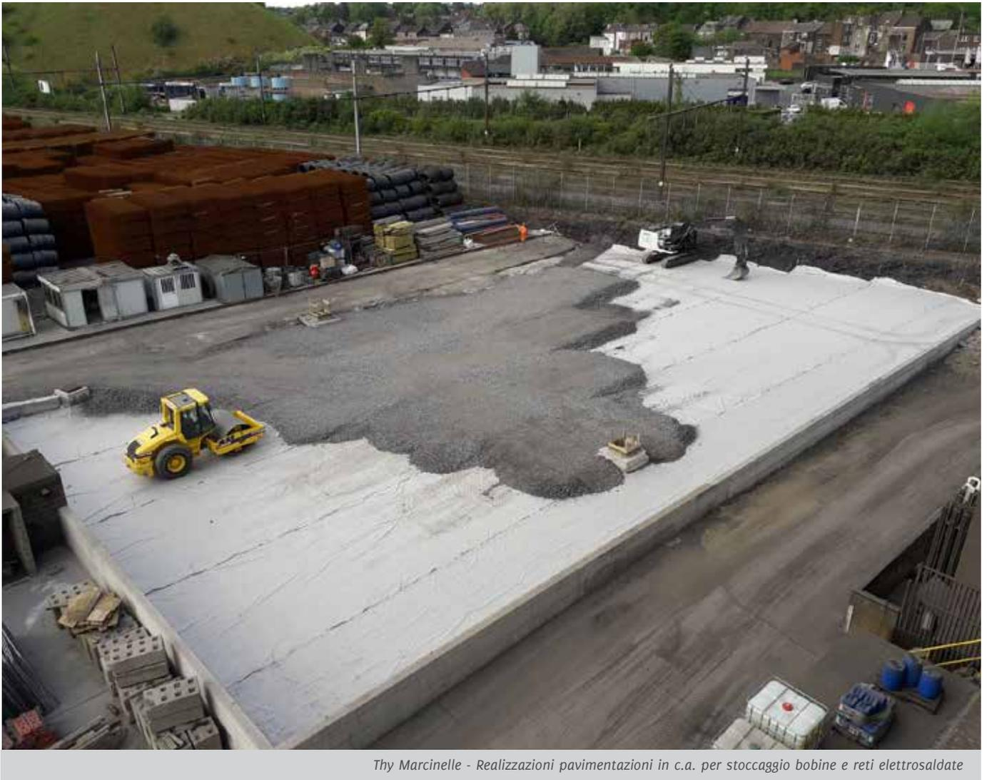
Thy Marcinelle - Realizzazioni pavimentazioni in c.a. per stoccaggio bobine e reti elettrosaldate
