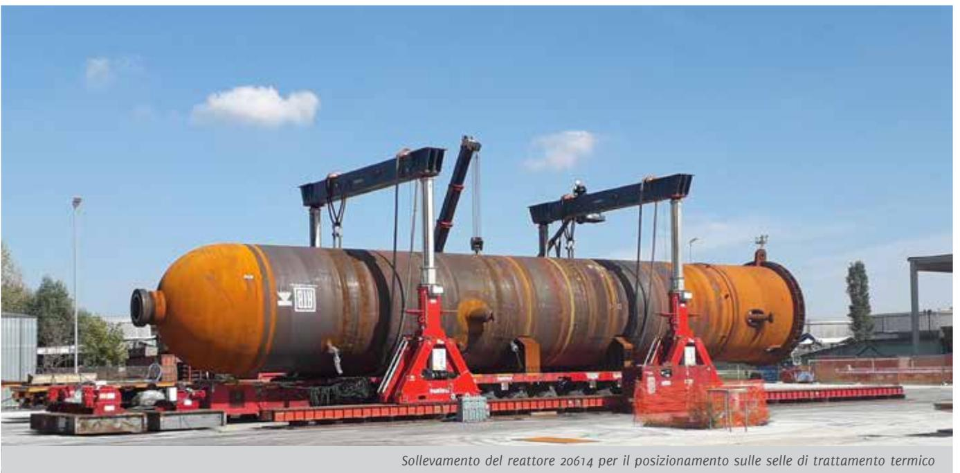
*Sollevamento del reattore 20614 per il posizionamento sulle selle di trattamento termico*
