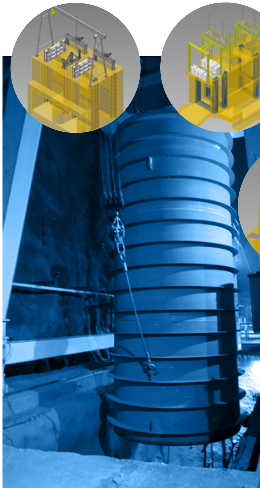
↑ Progetto idroelettrico di Alto Maipo (Cile). Le condotte dei pozzi verticali, già fabbricate e installate, facenti parte del primo lotto di componenti commissionati ad ATB.
