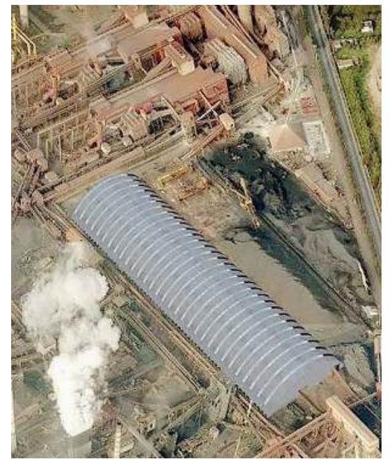
Il progetto. La copertura che realizzerà Atb
