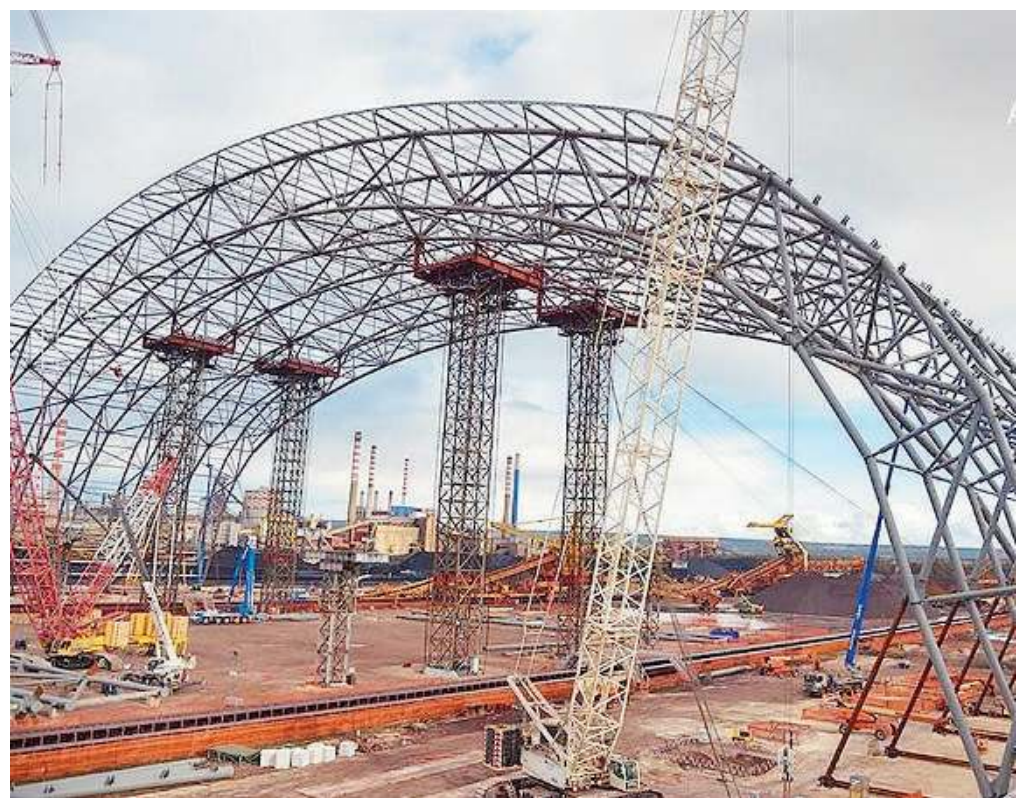
Il «cappello». La struttura che si sta realizzando a Taranto per proteggere la città dalle polveri
