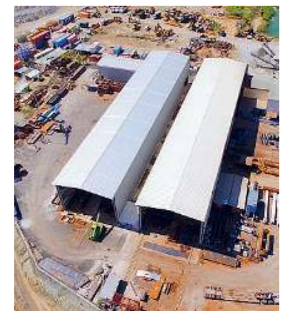
Il sito. Lo stabilimento temporaneo
